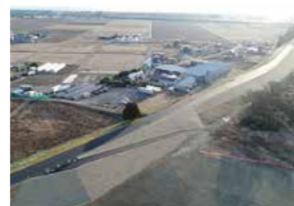
●名取川日辺種次地区築堤工事
