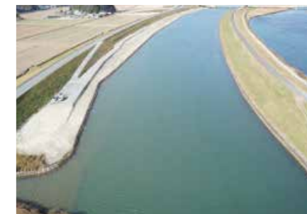
●吉田川野蒜地区河道掘削工事
