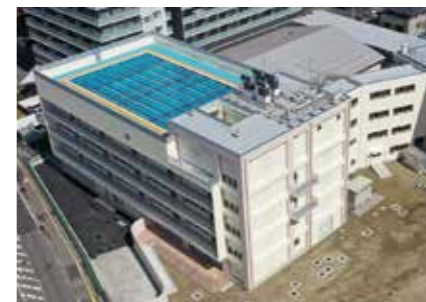
●仙台市立榴岡小学校増築及びプール改築工事
