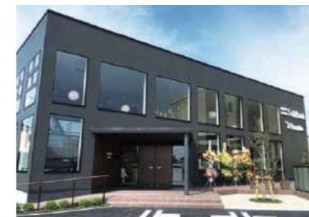
●ソフトバンク岩沼店新築工事
