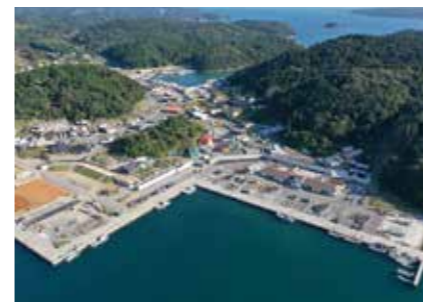
●表浜港防潮堤工事
