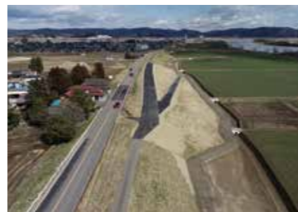
●阿武隈川下流江尻地区築堤工事
