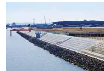
●南貞山運河河川災害復旧工事(10工区)
