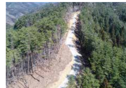
●只越第2林道(林業専用道)新設工事
