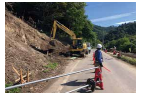
●道路土工掘削工
