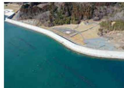
●伊勢畑防潮堤災害復旧(その2)工事
