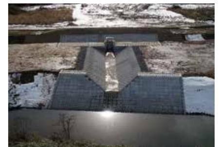
●二迫川排水樋管工事
