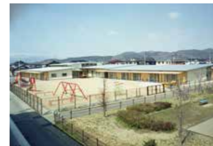
●船岡保育所移転新築工事
