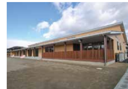
●白石みのり保育園新築工事
