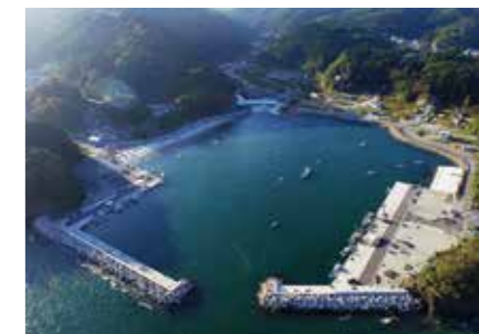
●北上漁港ほか1漁港災害復旧工事
