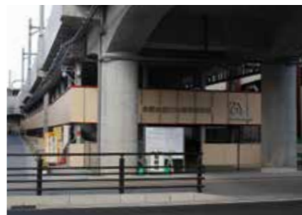
●多賀城駅自転車等駐車場新築(建築)工事
