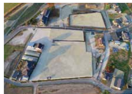
●中粕川地区復興まちづくり宅地造成工事
