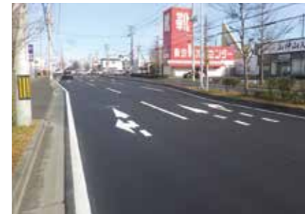
●(主)仙台塩釜線外1線舗装改修工事
