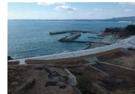
●赤牛漁港海岸保全施設整備事業防潮堤整備工事
