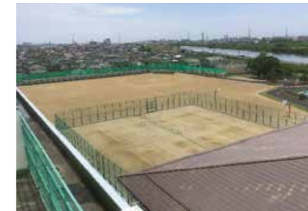
●仙台市立高砂中学校校庭整備工事
