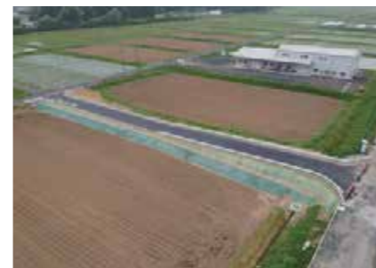
●気仙沼向洋高校敷地造成工事(道路改良)
