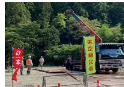
●敷き均し鉄板
