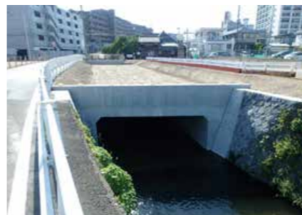
●七郷水路改築工事(舟丁工区)
