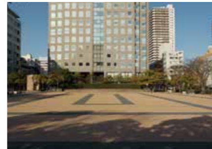
●市民広場舗装改修工事
