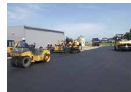
●駐車場舗装工事
