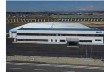
●ハイレックス宮城工場建設工事
