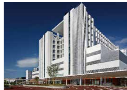
●仙台市立病院新築工事
