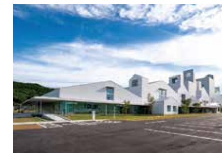
●石巻市複合文化施設建設工事
