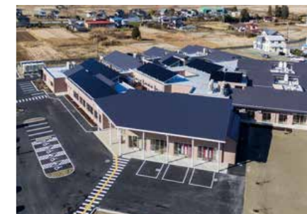
●障がい者支援施設「ふいぼう」新築工事(JV)
