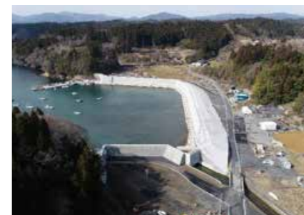
●細浦漁港災害復旧工事
