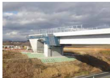
●後沢本線橋下部工工事
