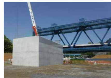
●歌津大橋下部工事
