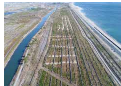
●仙台地区第27(2)治山工事
