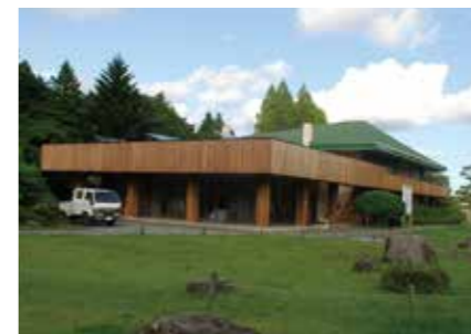
●県民の森中央記念館木質化等改修工事
