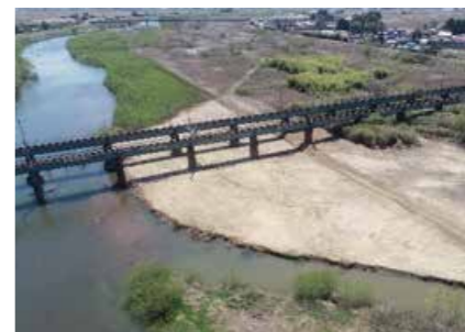
●迫川河道掘削工
