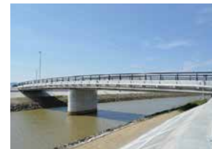
●東北地方太平洋沖地震橋梁災害復旧工事(長谷釜橋・赤江橋)
