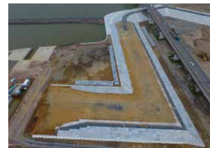
●旧北上川右岸雲雀野上流地区築堤工事
