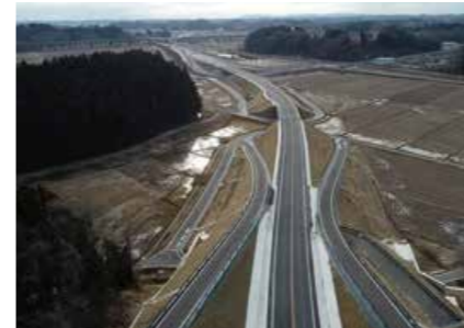
●みやぎ県北高速幹線道路(築館工区)舗装工事
