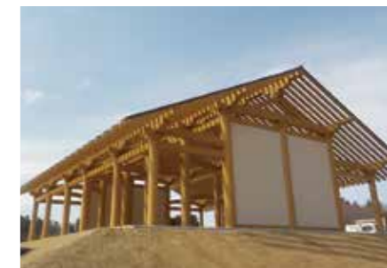
●多賀城跡附寺跡構造復元展示棟新築工事
