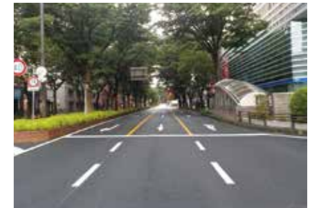
●(市)青葉通線(大町区)舗装改修工事
