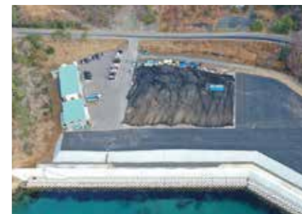
●荻浜港有田浜地区防潮堤(その2)外工事
