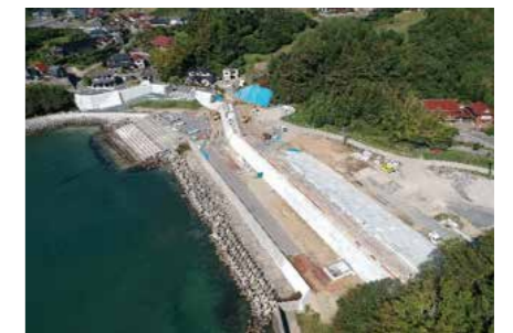
●神止浜漁港海岸保全施設整備事業防潮堤整備工事
