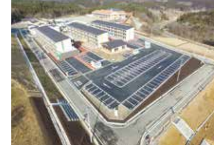
●戸倉災害公営住宅
