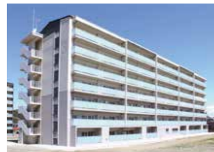
●北船岡町営住宅3号棟新築工事
